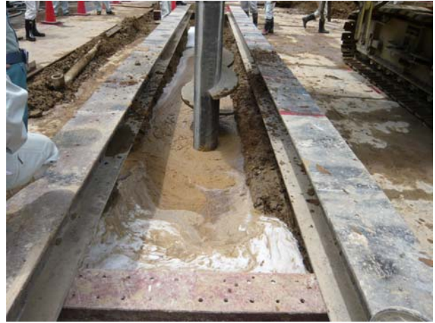
口絵写真-2 気泡掘削工法：AWARD-Ccw 工法
