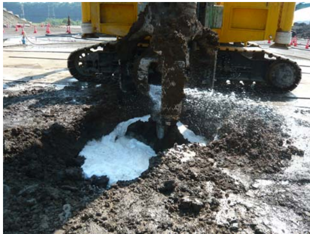
口絵写真-3 気泡掘削工法：AWARD-Demi 工法
