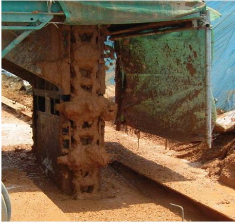
口絵写真-1 気泡掘削工法：AWARD-Trend 工法
